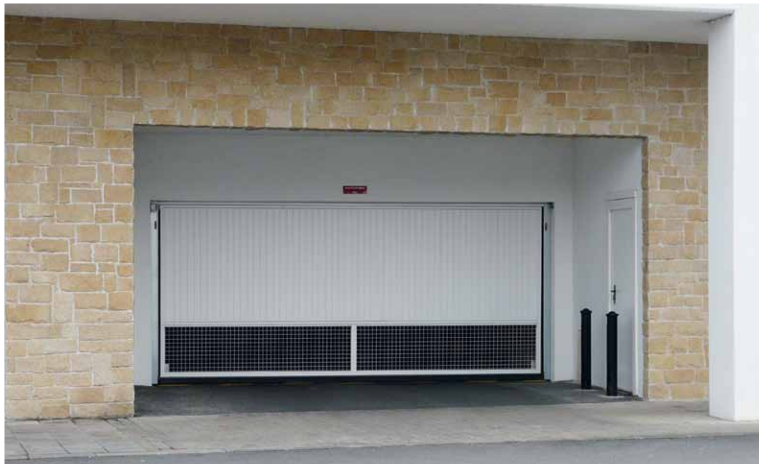
Trafimatic® Plus, ontwerp met verticale ribben, ventilatie door rooster met gepuntlaste mazen.
